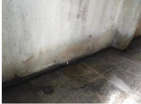
三车间：二乙酸和盐酸、亚磷酸、甲醛缩合反应生产双甘膦。**该车间已停用，不再生产双甘膦产品。**地面已硬化，无明显破损，具备防渗功能；生产设备周围地面较为整洁，无原料泄露；车间四周设有导排沟，各类管道、法兰和泵等均保养完好，法兰、阀门和管道连接良好，无滴漏。
