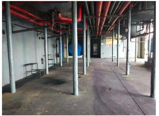
永固紫合成车间：完成烷基化，硝化，加氢，缩合闭环反应生成粗品永固紫。地面已硬化，有裂缝，具备防渗功能；生产设备周围地面较为整洁，无原料泄露；车间四周设有导排沟，各类管道、法兰和泵等均保养完好，法兰、阀门和管道连接良好，无滴漏。
