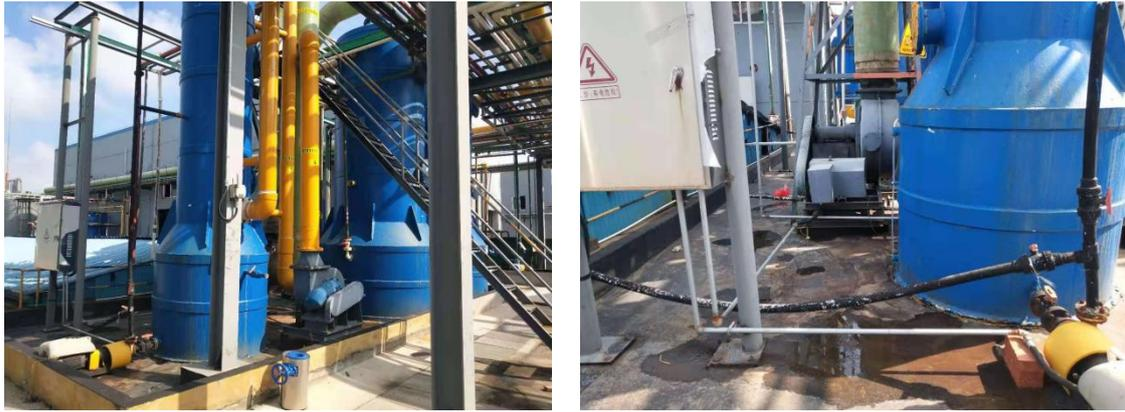
废气处理区：地面已硬化，无破损，具备防渗防腐功能；四周设有围堰；周围地面较为整洁；各类管道、法兰和泵等均保养完好，法兰、阀门和管道连接良好，无滴漏
