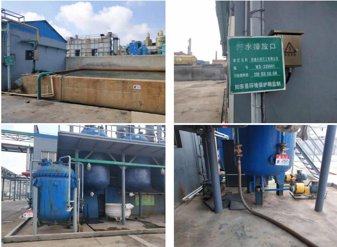
污水处理区:地面已硬化,无破损,具备防渗功能;四周设有围堰,导排沟;周围地面较为整洁;各类管道、法兰和泵等均保养完好,法兰、阀门和管道连接良好,无滴漏。
