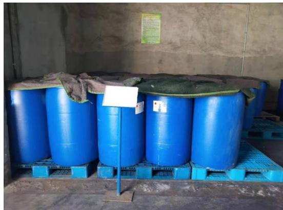
危化品仓库：存放危化品，危化品分类放置，摆放整齐，地面较整洁；仓库内地面均已硬化，无明显裂缝，具有防渗功能。
