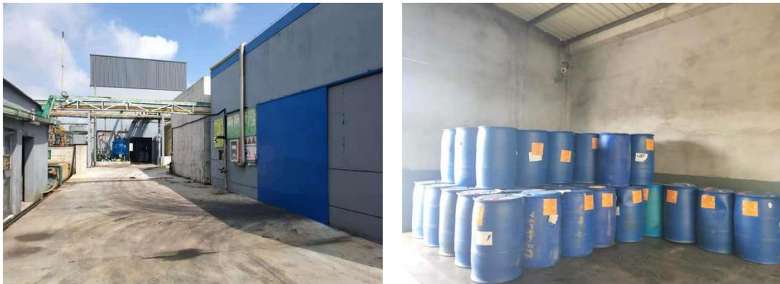
危险固废仓库：地面均已硬化，铺设环氧地坪，无明显裂痕；车间设有双锁；车间内外均有摄像监控；危废标识准确无误；车间四周设有收集槽。
